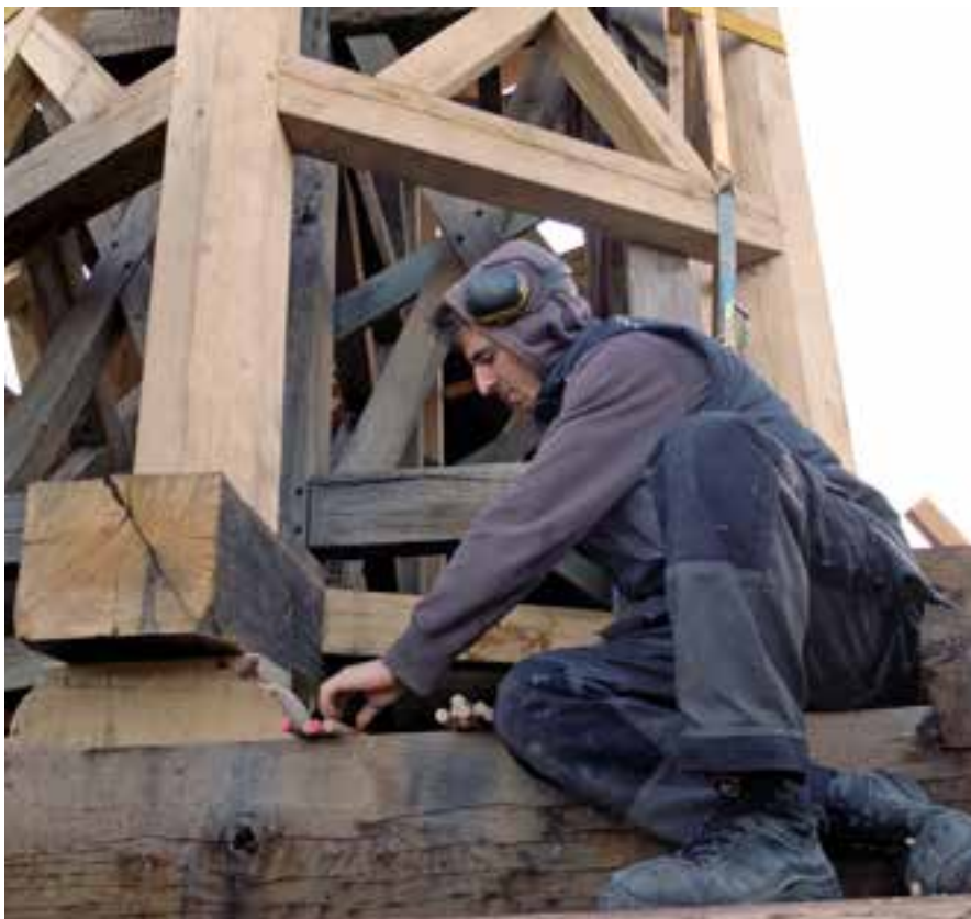
Charpentier, chantier-école. © AWaP
