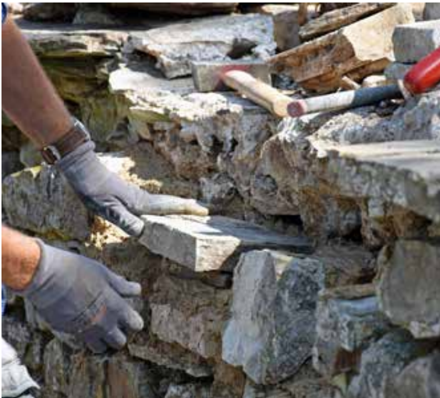
Consolidation du mur d'enceinte, août 2024, abbaye Notre-Dame du Val-Dieu, Aubel. © AWaP
