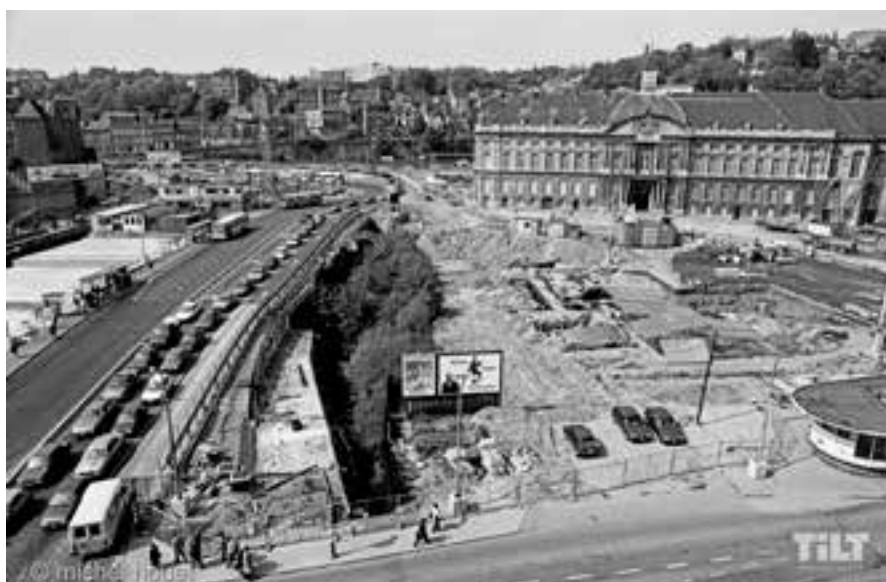
Chantier urbanistique de la place Saint-Lambert au début des années 1980, Liège.
