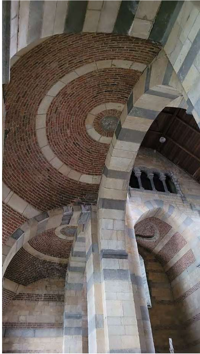
STRUCTURE ET VOÛTAISON : BAS-CÔTÉ, NEF CENTRALE, NARTHEX. PHOTO : AFP – AWAP - DZC
