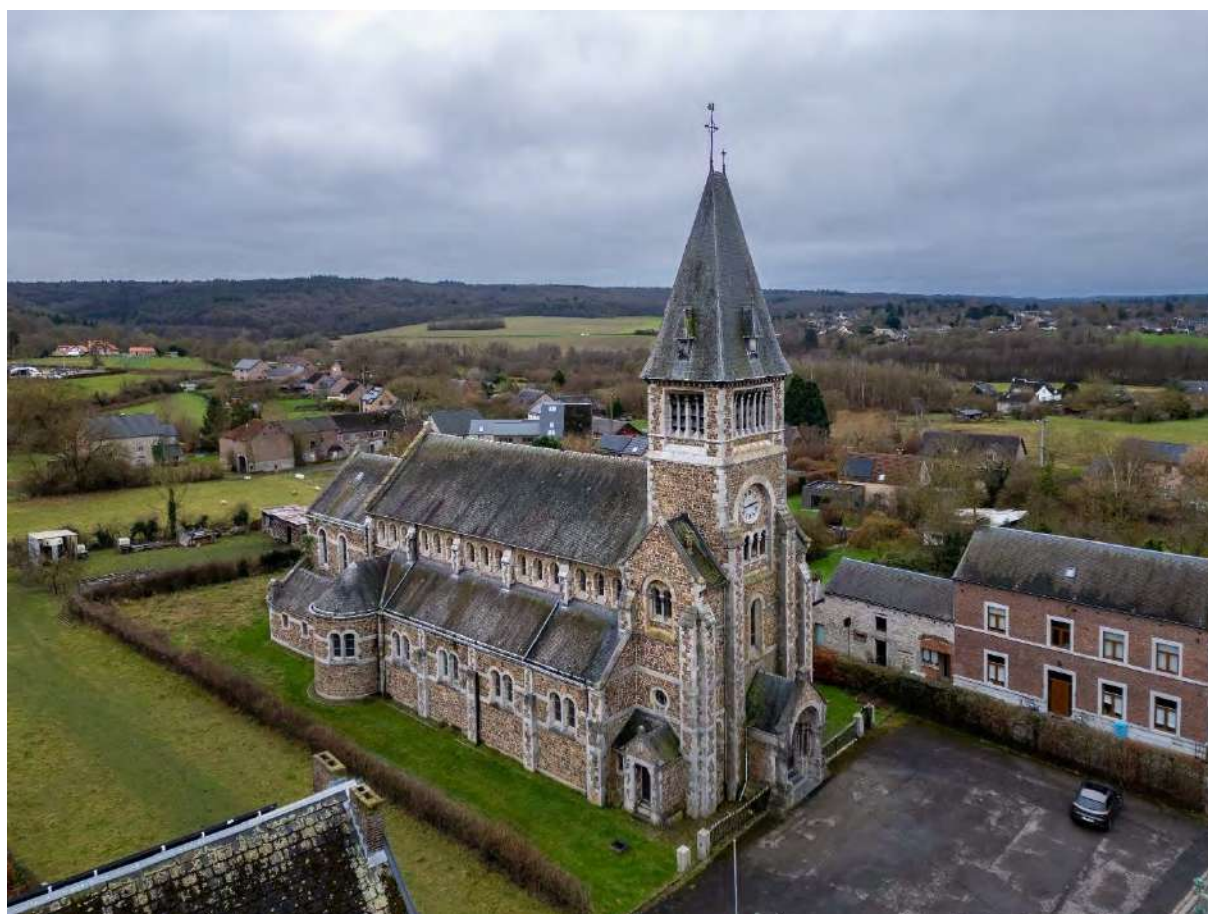
VUE NORD-OUEST. PHOTO VINCENT ROCHER, NICOLAS EVRARD (STAGIAIRE) - AWAP – DST
