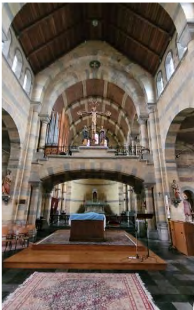
VOÛTE SURBAISSÉE DU CHŒUR, À BERCEAU PANNEAUTÉ AVEC DALLES EN BRIQUE DANS UNE STRUCTURE EN PIERRE BLANCHE. PHOTO : AFP – AwAP - DSC
