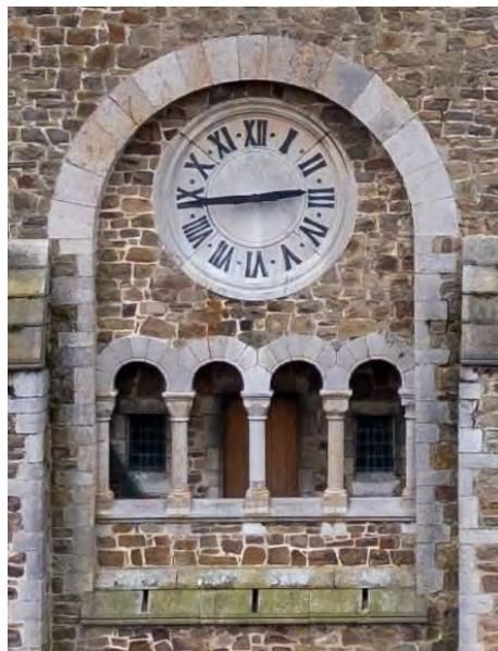
FAÇADE DE LA TOUR-COCHER, LOGGIA. PHOTO (DÉTAIL) : VINCENT ROCHER ET NICOLAS EVRARD (STAGIAIRE) – AWAP - DST
