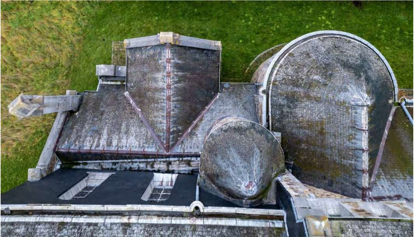
VOLUMES SECONDAIRES À LA DROITE DU CHŒUR : ACCÈS, TRIBUNE DE SAUVAGE-VERCOUR AVEC SOUCHE DE CHEMINÉE, MAGASIN, SAS VERS LE JUBÉ ET TOURELLE DE L'ESCALIER DU JUBÉ. BRAS DROIT DU FAUX-TRANSEPT, ABSIDE
