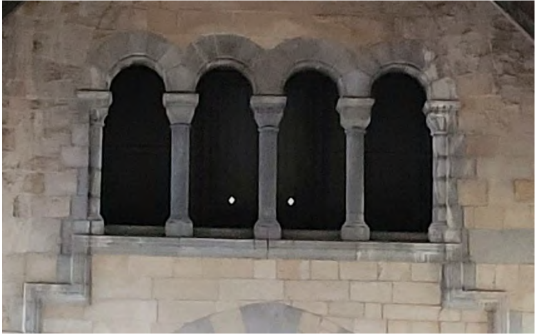
MUR INTÉRIEUR DU MASSIF, LOGGIA. PHOTO (DÉTAIL) : VINCENT ROCHER ET NICOLAS EVRARD (STAGIAIRE) – AWAP - DST
