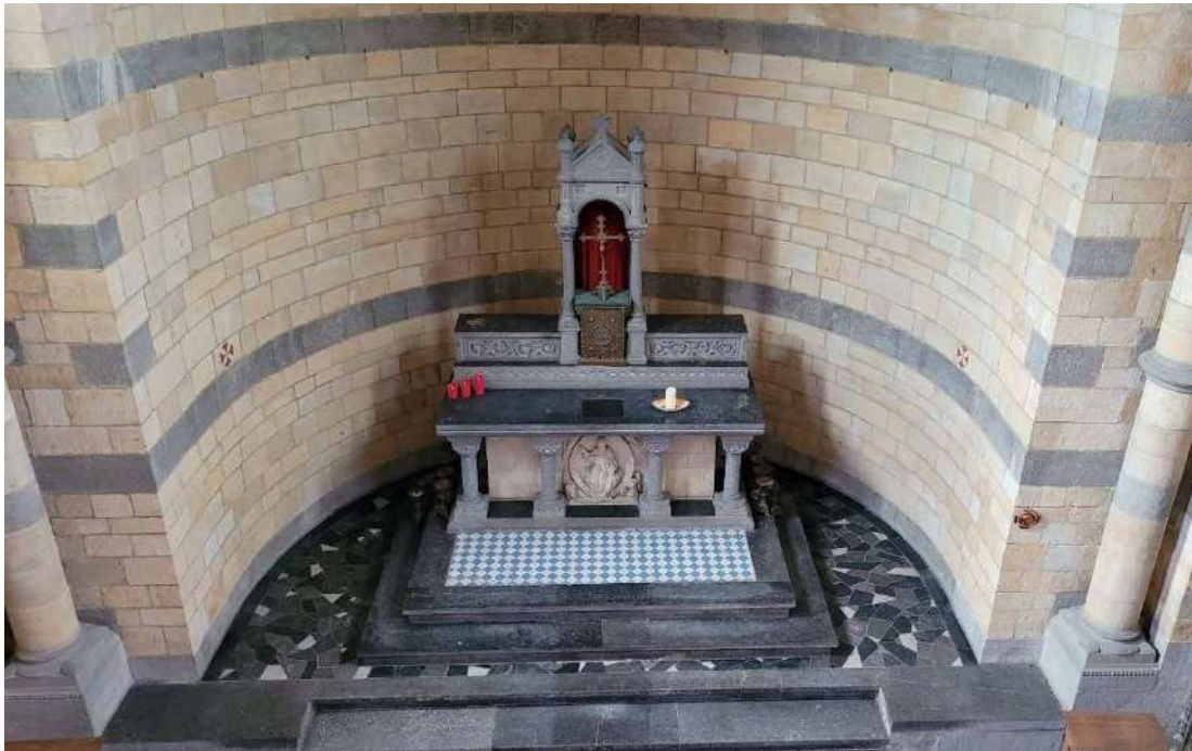
PAVAGE EN MOSAÏQUE DU CHŒUR, TECHNIQUE UTILISÉS AUSSI DANS LES SOCLES DES AUTELS LATÉRAUX. PIERRE POLIE. PHOTO : VINCENT ROCHER ET NICOLAS EVRARD (STAGIAIRE) – AWAP - DST
