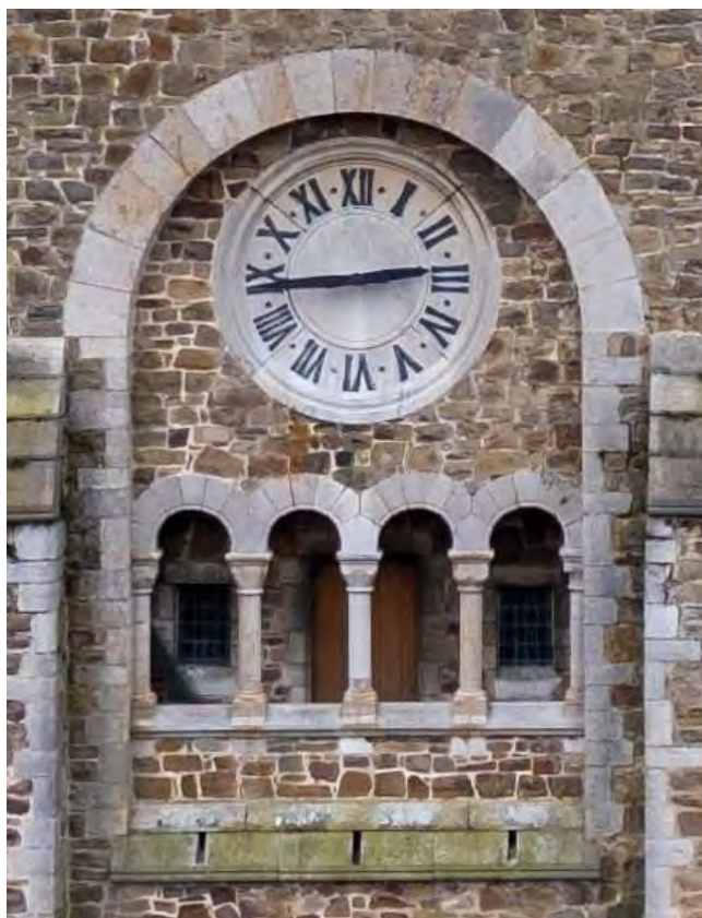
HORLOGE EN FACE AVANT DE LA TOUR, CADRAN-SQUELETTE EN PIERRE TAILLÉE HEURES ET DEMI-HEURES (POINTS) TAILLÉS EN ÉPARGNE DANS LA PIERRE, PEINTS EN NOIR, AIGUILLES EN FER FORGÉ.
