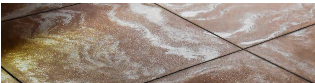
RECOUVREMENT DES COULOIRS DU REZ-DE-CHAUSSÉE (LOCAUX DE SERVICE) : CIMENT ROUGE ET BLANC COULÉ ET JOINTS EN BOIS. PHOTOS : ERIC HANCE (2024)
