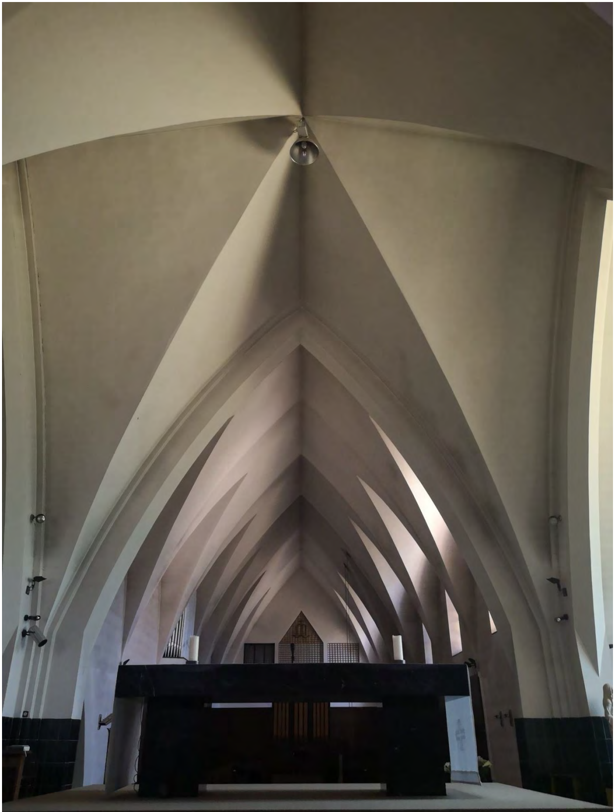
AUTEL ET VOUTE DE LA CROISEE DU TRANSEPT. PHOTO : FRANCIS TOURNEUR
