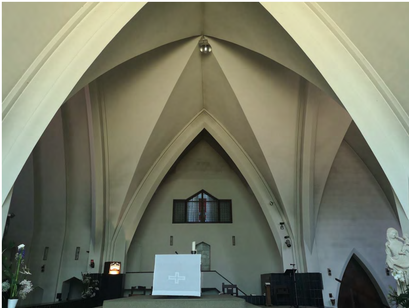
CROISÉE D'OGIVES DE LA CROIX DU TRANSEPT. PHOTO : FRANCIS TOURNEUR
