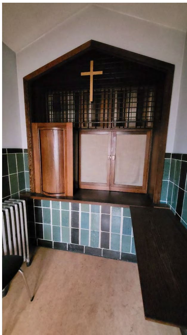
PARLOIR DE L'ABBESSE, COTE VISITEUR. ENCORE EN PLACE : LE MUR ET LA GRILLE, LES VOILES MASQUANT LES VUES, LE TOUR ET LA FENETRE DE PARLOIR
