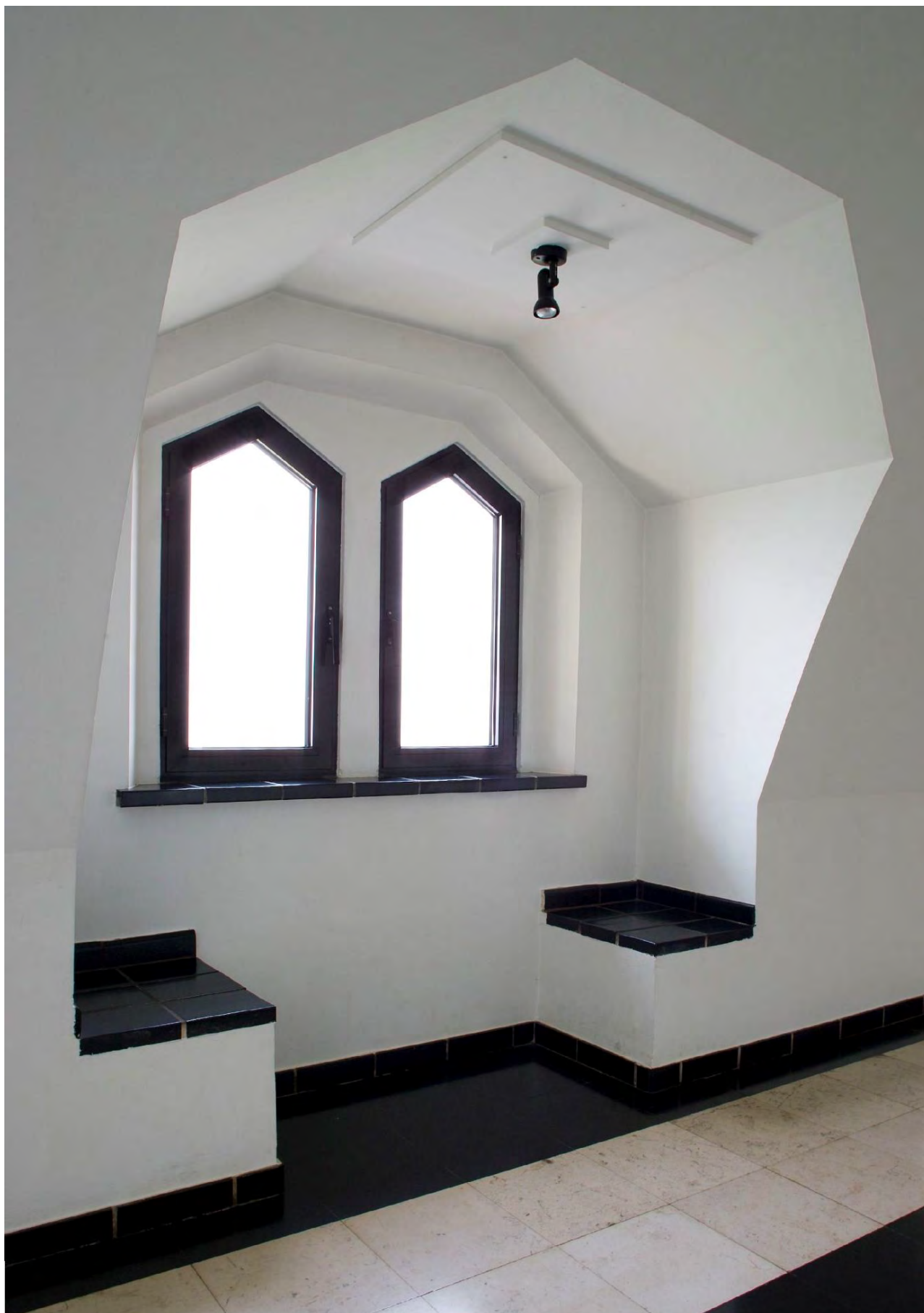
BAIE SOUS NICHE ENCADREE PAR DES COUSSIEGES. PHOTO : CC BY 4.0 KIK-IRPA, BRUSSELS (BELGIUM), CLICHÉ X032502]
