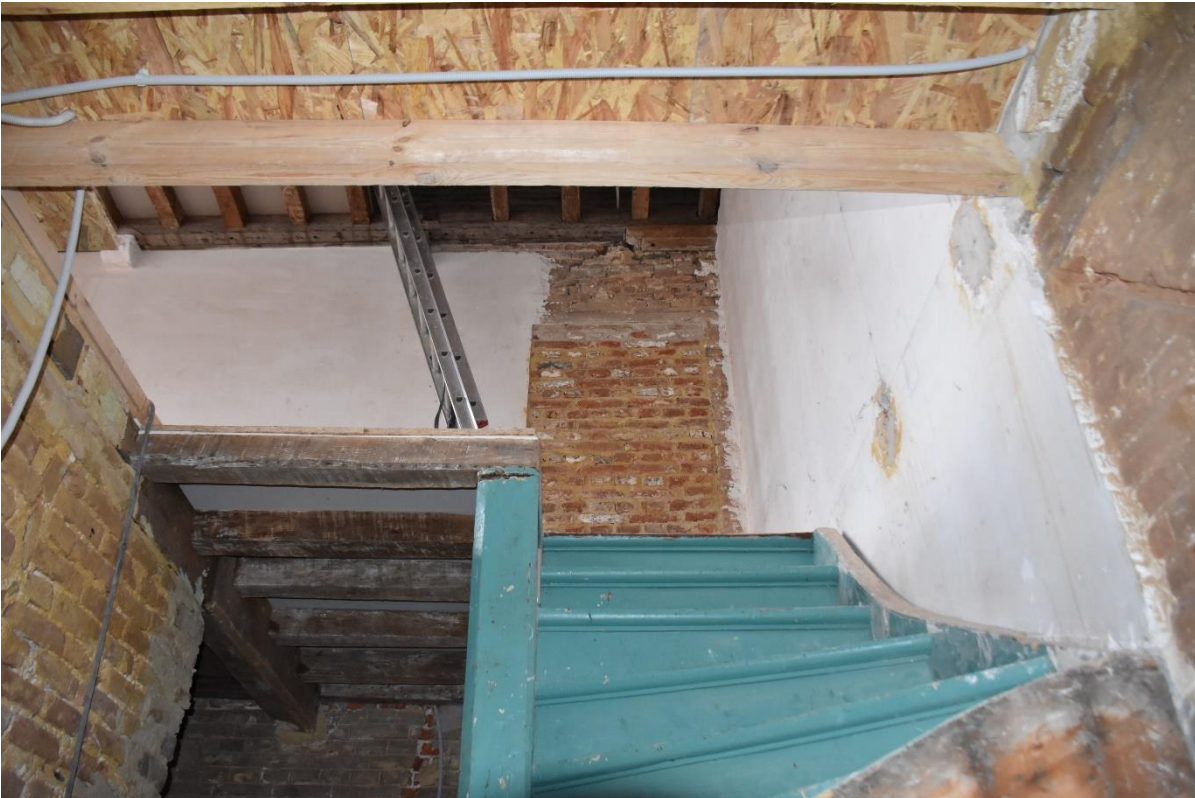
Cage d'escalier (pas d'intérêt patrimonial)
