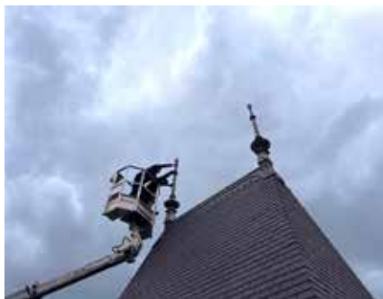
| Restauration de la chapelle castrale d'Enghien
