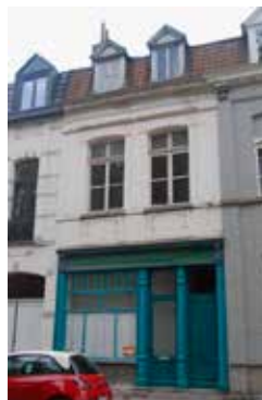
Façade de l'ancien commerce rue de l'Épinette 26, Tournai
