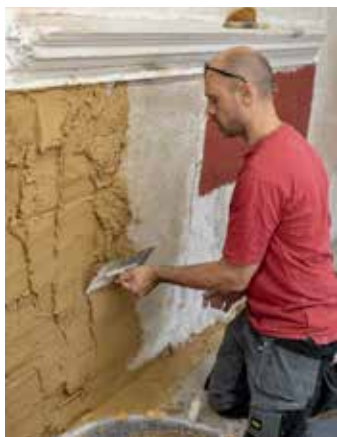
Réalisation d'enduits en terre à la Paix-Dieu dans le cadre de la formation « Terre crue ». © provincedeliege
