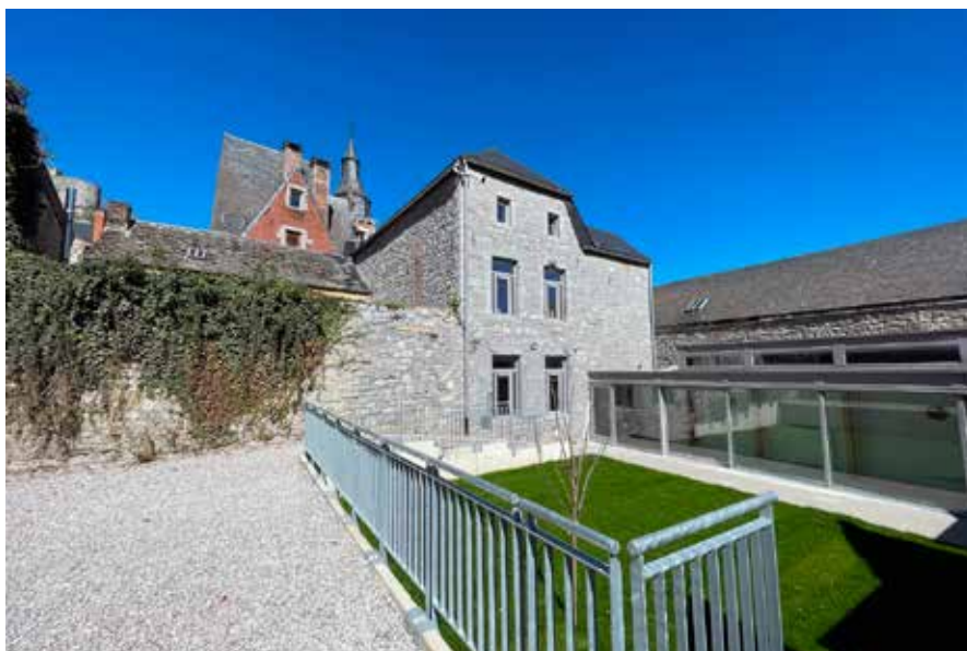
Vue du pignon sud de la Maison Monin depuis le jardin, Bouvignes-sur-Meuse, Dinant. © MPMM
