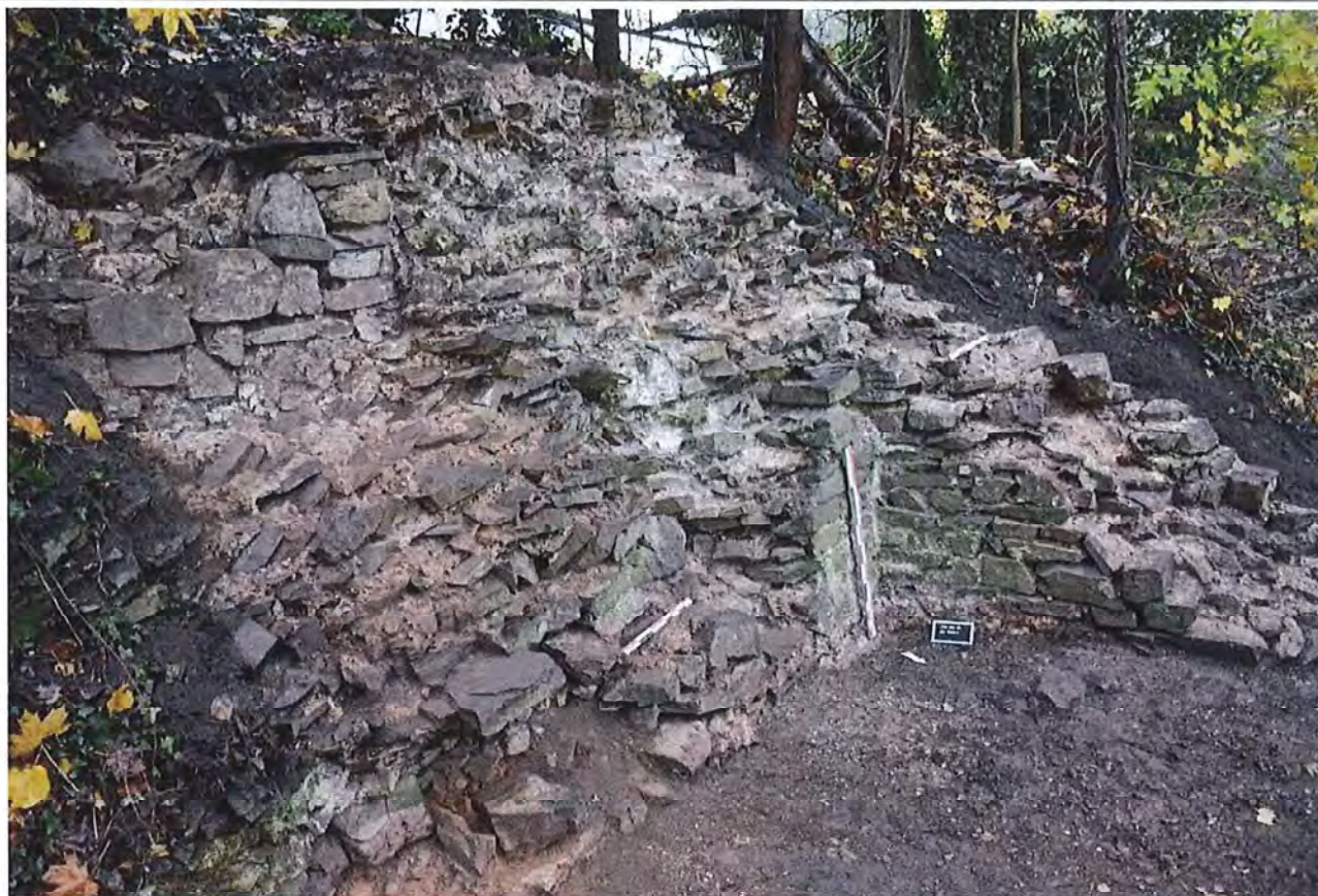
1. La jonction de la courtine et de la tour 4 sur le flanc nord de l'enceinte en 2023.
