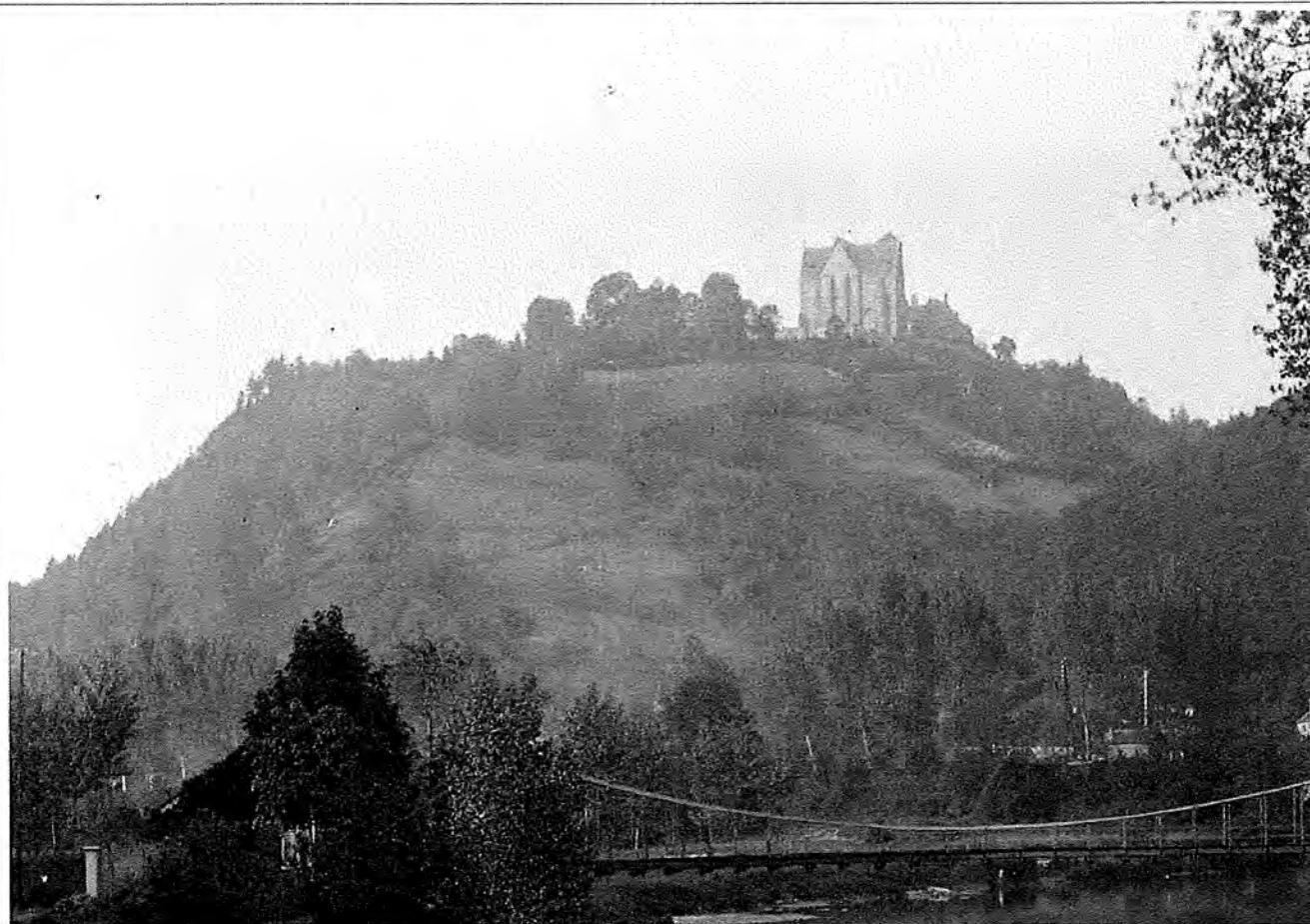
4. Détail de la vue précédente, montrant les travaux interrompus de la basilique.
