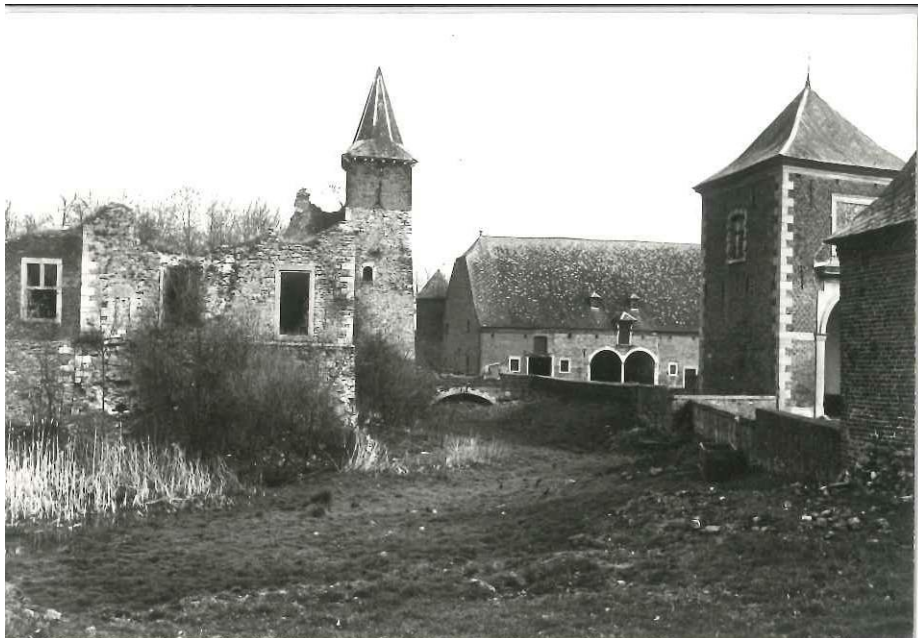
D) La vieille tour du château : le toit et le dernier étage se sont effondrés et n'ont jamais été restaurés.
